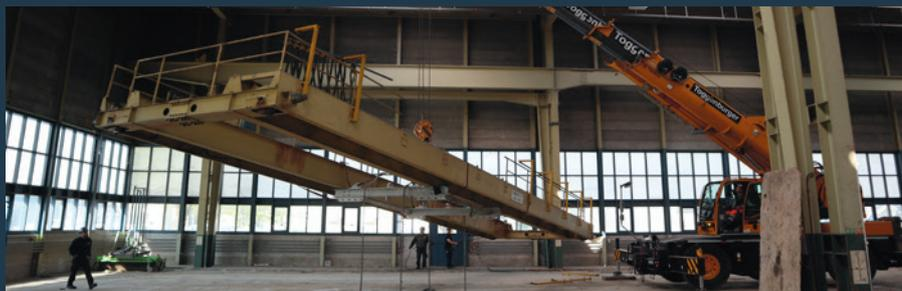
Abbau eines 10 Tonnen schweren Hallenkranes
