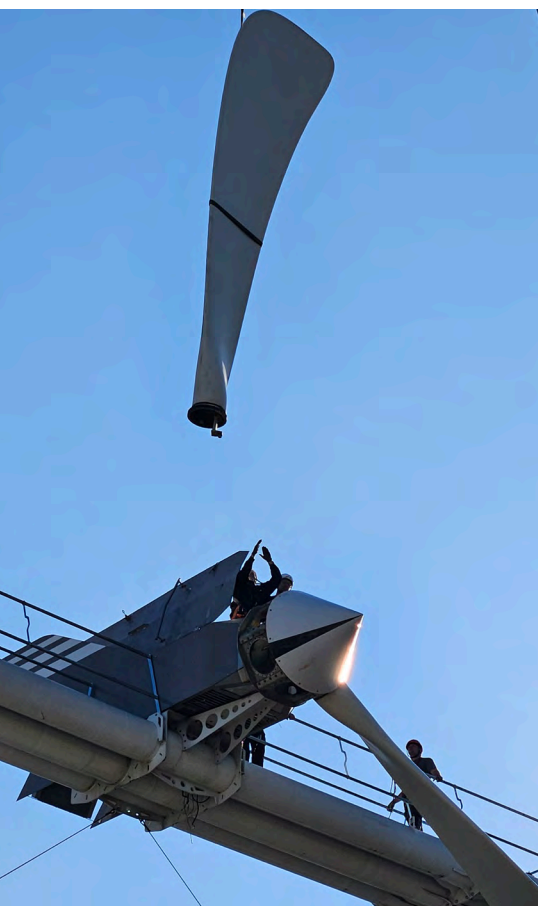
Demontage eines Rotorblatts
