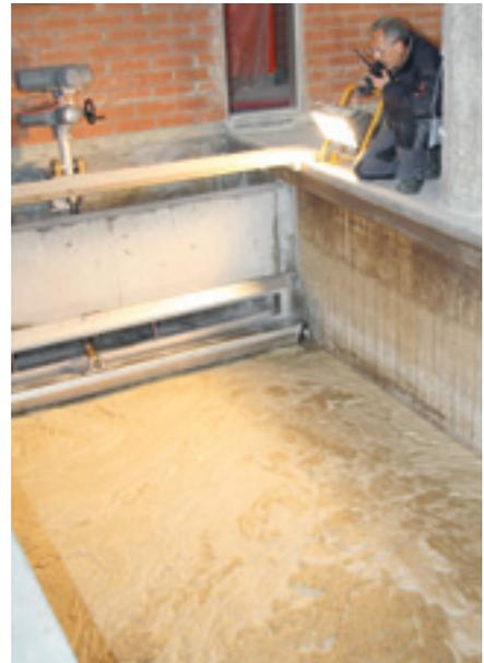
Rosario Bresci testet im Funkkontakt mit dem Maschinisten die neue Klappe. Unten ist die im Sand ausgefilterte dicke Schmutzschicht zu sehen, die auf der Wasseroberfläche schwimmt.
