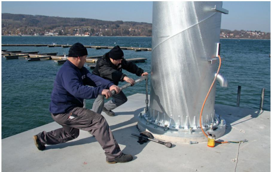
Mit einem riesigen Drehmomentschlüssel fixieren unsere Techniker Martin Hofmann und Fabian Oehninger die Kransäule mit grossen Schrauben auf dem Fundamentsockel.
