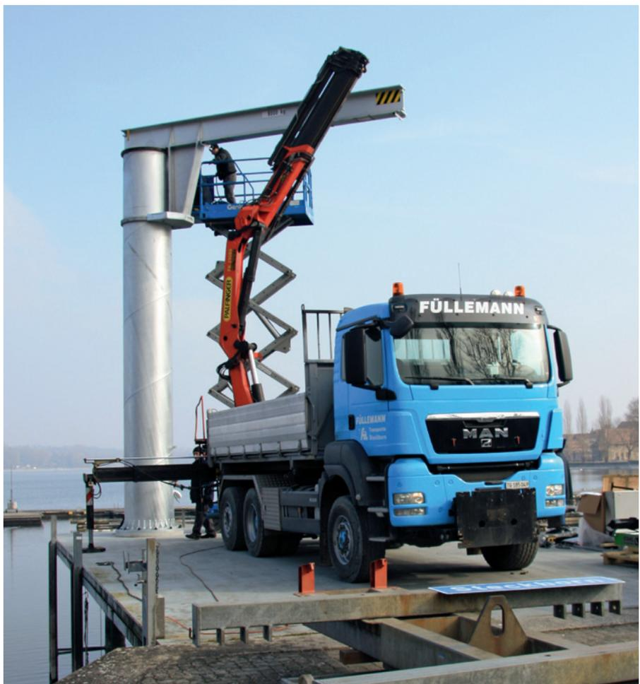
Montage des Auslegers: Die maximale Tragkraft des Krans beträgt 8'000 kg.
