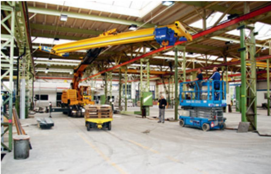
*Dieser Pneukran mit speziell kurzem Hydraulik-Ausleger hievt die Hallenkrane auf die Fahrbahn.*
